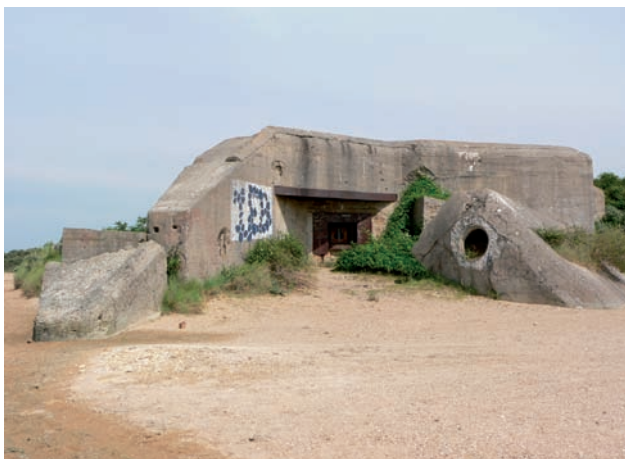
Kasematte im ehemaligen Stützpunkt Stp-5 im Ornedelta
